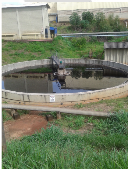
Foto 03: Vista da ETE
