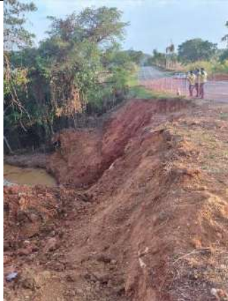
Figura 7 – Obra de recuperação 1
