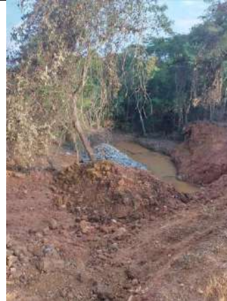
Figura 8 – Obra de recuperação 2
