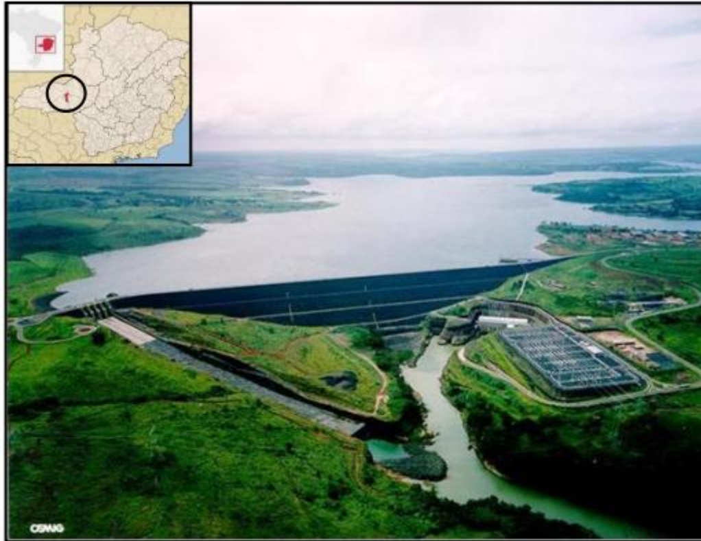
Figura 01: Vista aérea da UHE Nova Ponte e detalhe de sua localização no estado de Minas Gerais.
