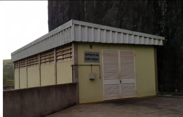
Foto 05: Depósito de óleos e graxas. Fonte: Relatório IC (documento SEI nº 21785062).
