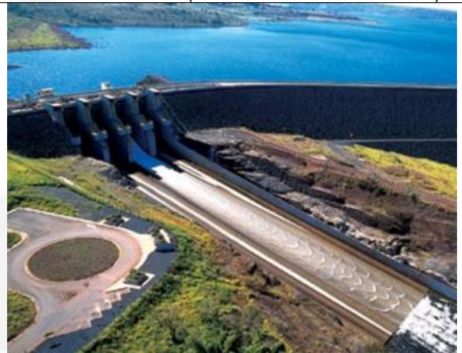
Foto 04: Vertedouro. Fonte: Relatório IC (documento SEI nº 21785062).
