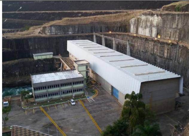
Foto 01: Casa de Força. Fonte: Relatório IC (documento SEI nº 21785062).
