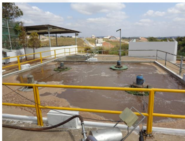
FOTO 04. Tanque de Aeração da ETE
