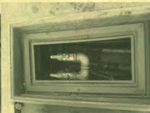
Foto 6: Câmara de contenção da bomba de óleo diesel.
