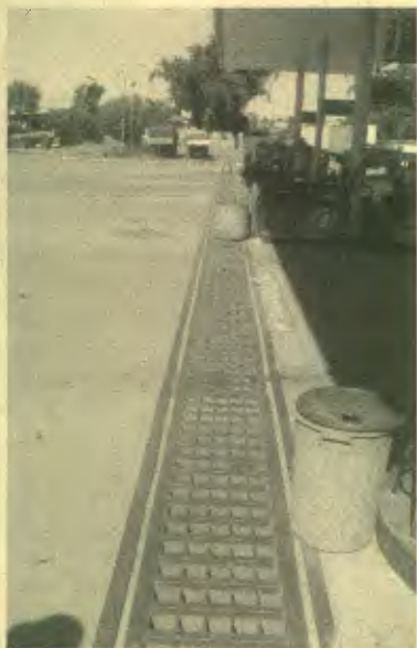
Foto 3: Canaleta de drenagem da pista de abastecimento
