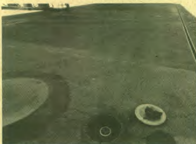
Foto 5: Câmara de contenção de descarga com dispositivo para descarga selada (anel).
