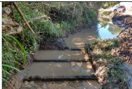
Figura 6: sistema de drenagem e bacia de decantação.
