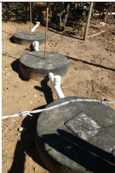
Figura 7: Sistema fossa séptica biodigestora (EMBRAPA)
