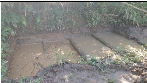
Figura 5: Bacia de decantação
