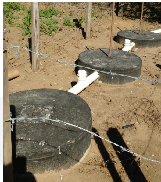
Figura 8: Sistema fossa séptica biodigestora (EMBRAPA)
