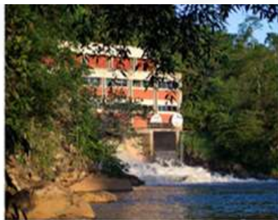
Casa de força
