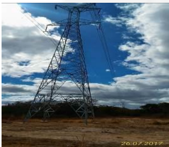
Foto 13. Torres da linha de transmissão próximas à APP
