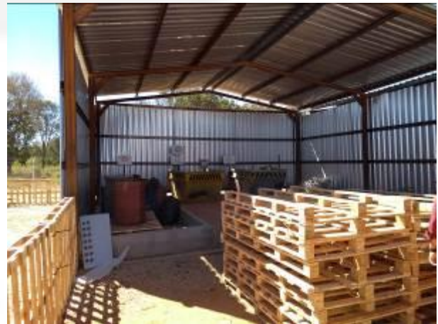
Foto 02. Galpão de Armazenamento de resíduos
