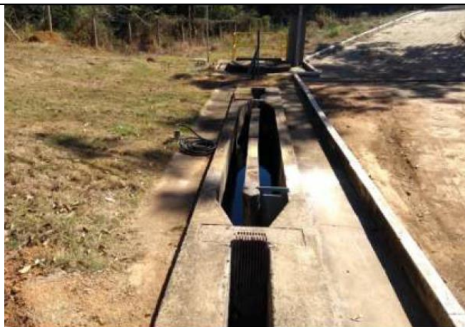
FIGURA 05. Tratamento Preliminar e Elevatória no fundo. FONTE: RAS ETE Funilândia, 2020.
