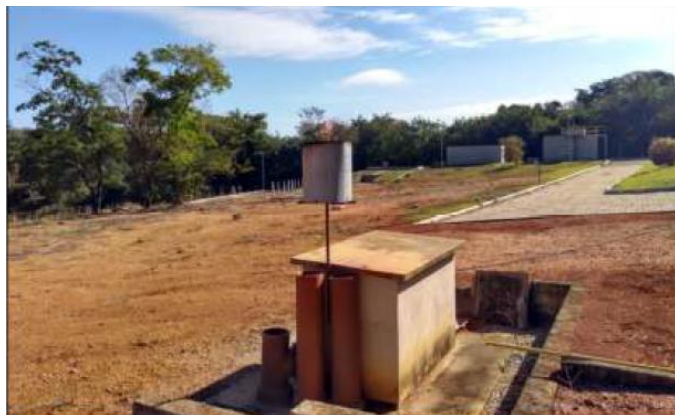
FIGURA 11. Queimador de biogás. FONTE: RAS ETE Funilândia, 2020.
