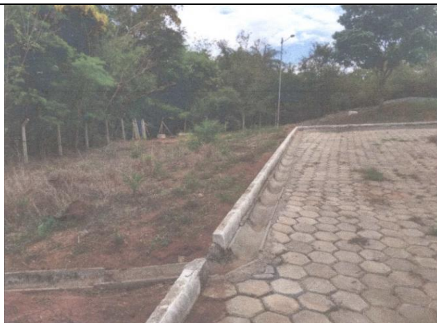
FIGURA 07. Talude interno no empreendimento e Sistema de drenagem de água pluvial. FONTE: RAS ETE Funilândia, 2020.
