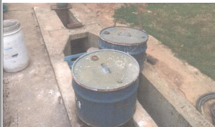
FIGURA 14. Tambores utilizados para o armazenamento temporário dos resíduos sólidos retirados da grade do tratamento preliminar. FONTE: RAS ETE Funilândia, 2020.
