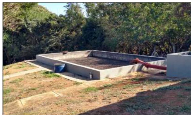
FIGURA 08. Leito de secagem. FONTE: RAS ETE Funilândia, 2020.
