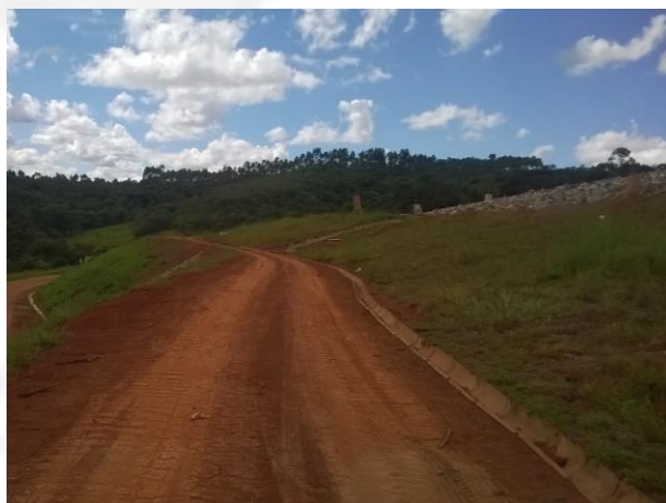
Foto 02. Canaleta de drenagem pluvial nas bermas do aterro
