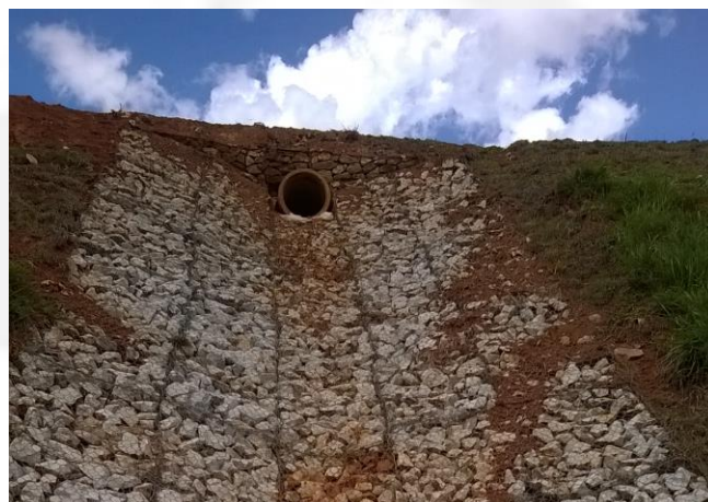
Foto 04. Colchão Reno no talude no aterro
