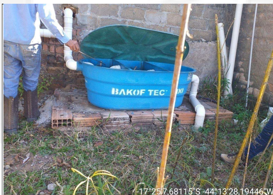
Figura 32: CSAO instalada no galpão oficina.
