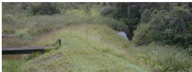
Barragem do rio quilombo
