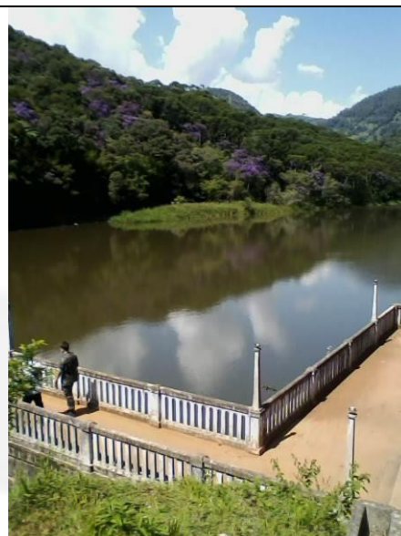
Vista do entorno a partir do barramento
