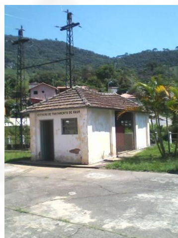
Tratamento de água
