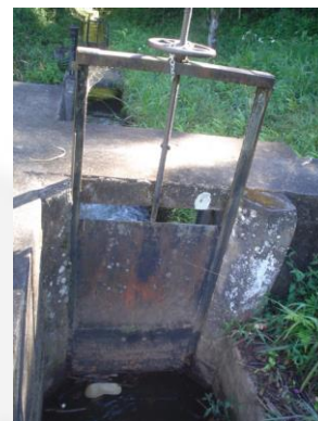
Detalhe da comporta do canal de desvio da barragem do rio Quilombo
