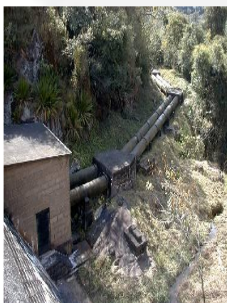
Conduto forçado da usina principal
