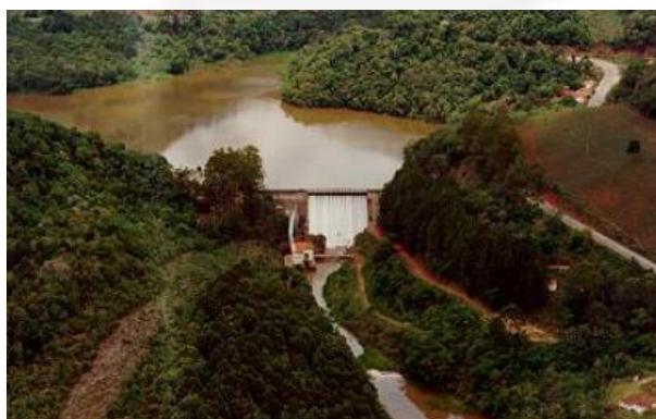
Barragem de regularização e usina auxiliar
