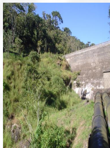
Barragem da usina principal
