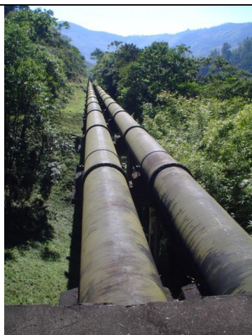
Extensão do conduto forçado
