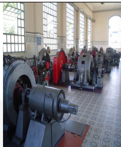
Casa de Máquinas
