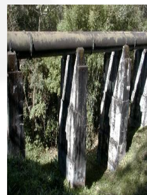
Detalhe dos blocos de sustentação
