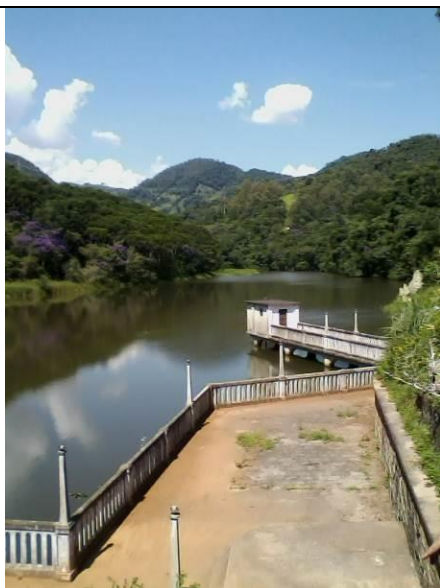
Vista do entorno a partir do barramento
