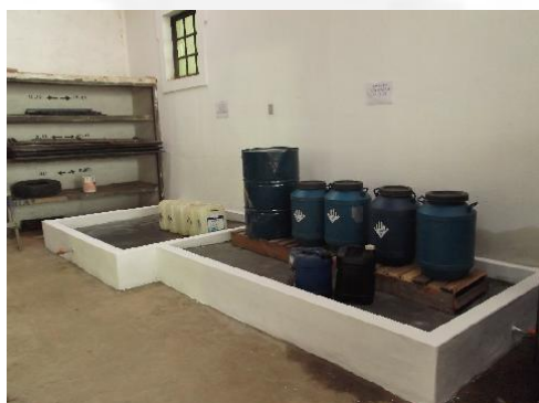
Bacias de contenção no almoxarifado
