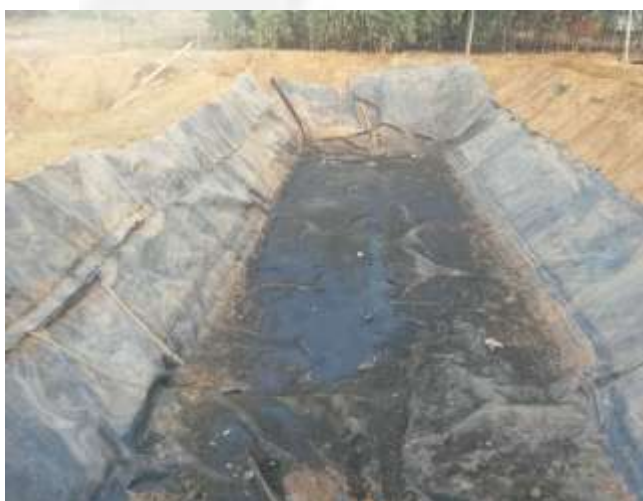
Figura 02: Segunda lagoa de estabilização em construção.
