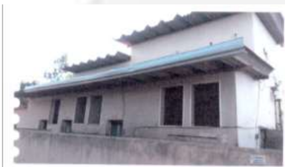
Figura 06: Telhados onde foram instaladas canaletas de captação de águas pluviais.
