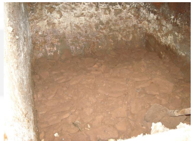
FOTO 04. Armazenamento Temporário de Lodo da ETE Seco
