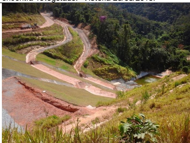
Fotografia 11: Barragem de rejeitos em operação. Observa-se o maciço do barramento e o dique de contenção de sedimentos. Vistoria 26/08/2015.
