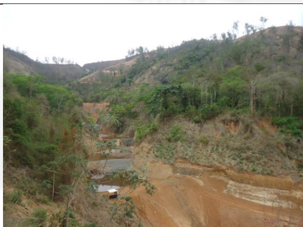
Fotografia 03: Área do talvegue na qual pode-se visualizar os barramentos iniciais que permitiram a operação da UTM. Observa-se também o corte realizado no talude esquerdo. Vistoria 24/10/2014.
