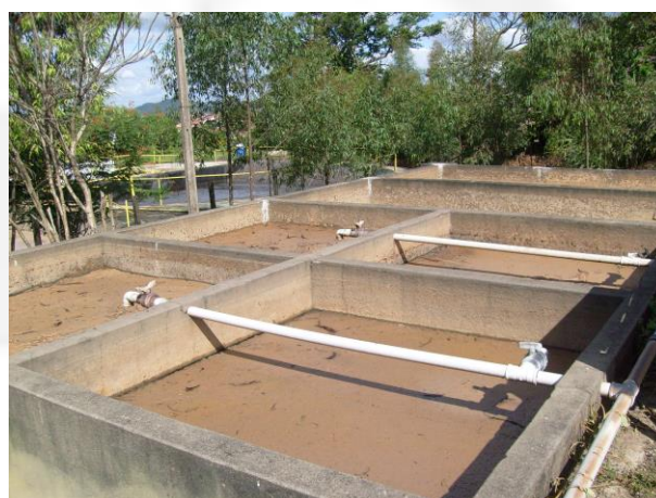
Leitos de secagem de lodo
