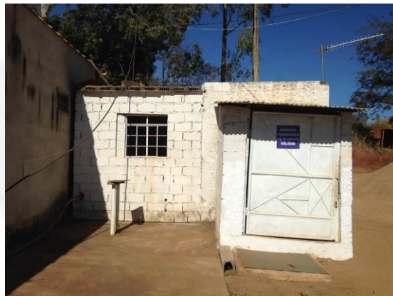
Foto 02. Vista do depósito temporário de resíduos sólidos classe I – placa azul - provido de caixa de contenção. Ao lado janela do escritório localizada na parede do fundo.
