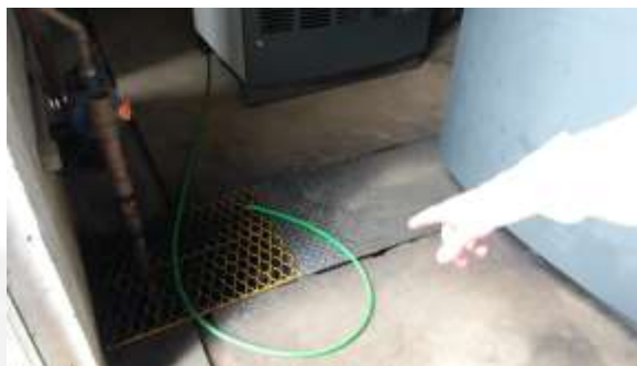
Canaletas na sala dos compressores
