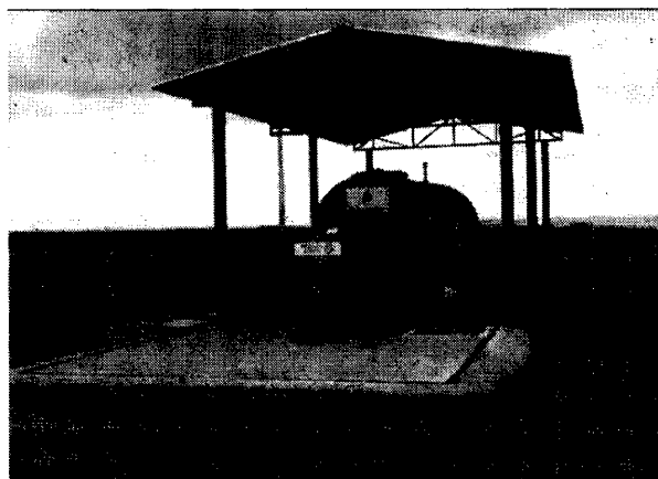
Foto 04. Tanque de combustível
