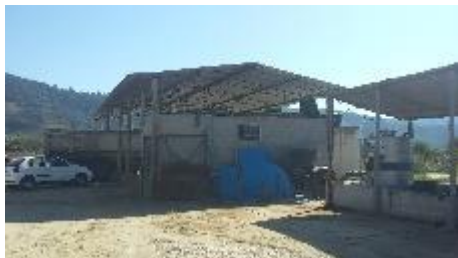
Foto 01. Galpão de manutenção e ponto de abastecimento.
