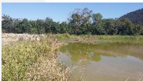
Foto 05. Tanque de decantação.
