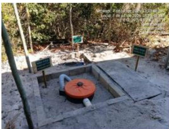
Foto 12. Biodigestor.
