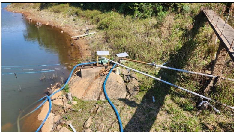
Figura 11 – Bombas instaladas próximo à estrutura de captação. Fonte: RISE -2023.
