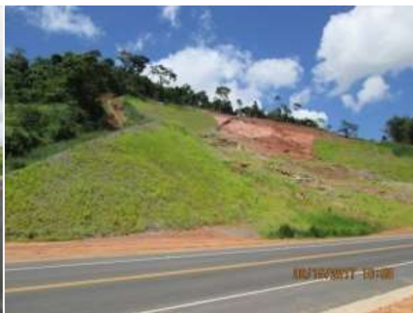
Trecho concluído com faixa de domínio em recuperação Revegetação de faixa de domínio e talude a ser estabilizado
