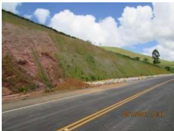
Trecho concluído com faixa de domínio em recuperação Revegetação de faixa de domínio e talude a ser estabilizado
