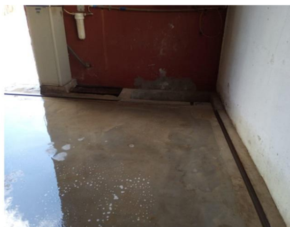
Figura 11: Detalhe da área da oficina com canaletas de contenção (a esquerda) e caixa SÃO instalada no tanque de lavagem de peças (a direita) . Fonte: informações complementares.
