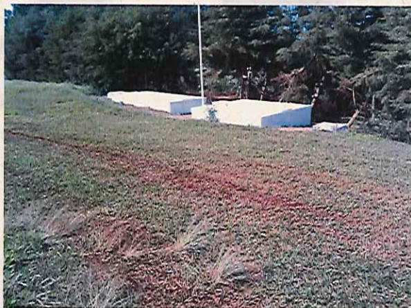
Figura 2. Fossas sépticas - próxima ao refeitório
