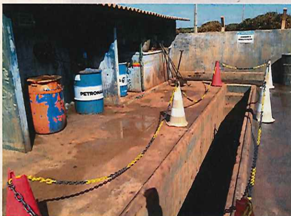
Figura 11. Área de lavagem e manutenção
