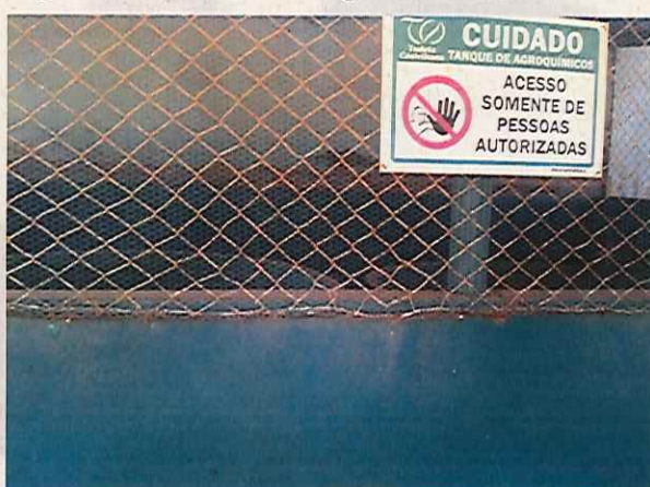
Figura 14. Tanque de agroquímicos
