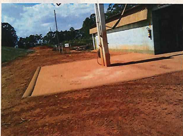
Figura 13. Local de abastecimento com calda de defensivos
