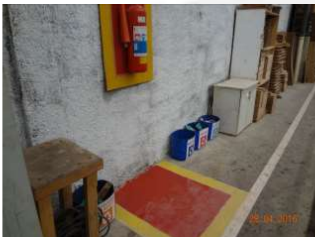
Extintor adaptado na área de produção
