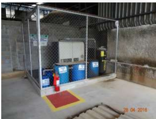
Localização do compressor com os tambores de tratamento da purga gerada
