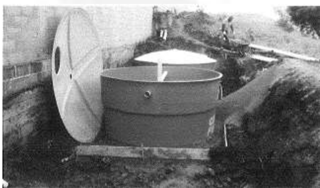
Nova ETE sanitária sendo instalada
