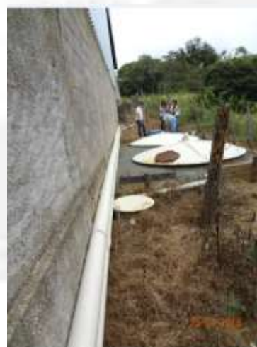
Constatação em vistoria o sistema de tratamento sanitário já implantado localizado próximo ao sistema antigo.
