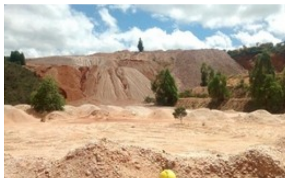
Foto 04. Taludes da “cava 1” em reconformação topográfica, em área próxima à portaria da empresa.
