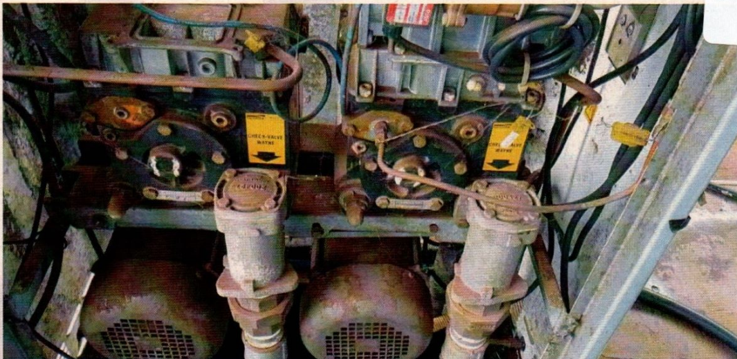
Foto Vistoria: Bomba de combustível dotada de "check valve"
