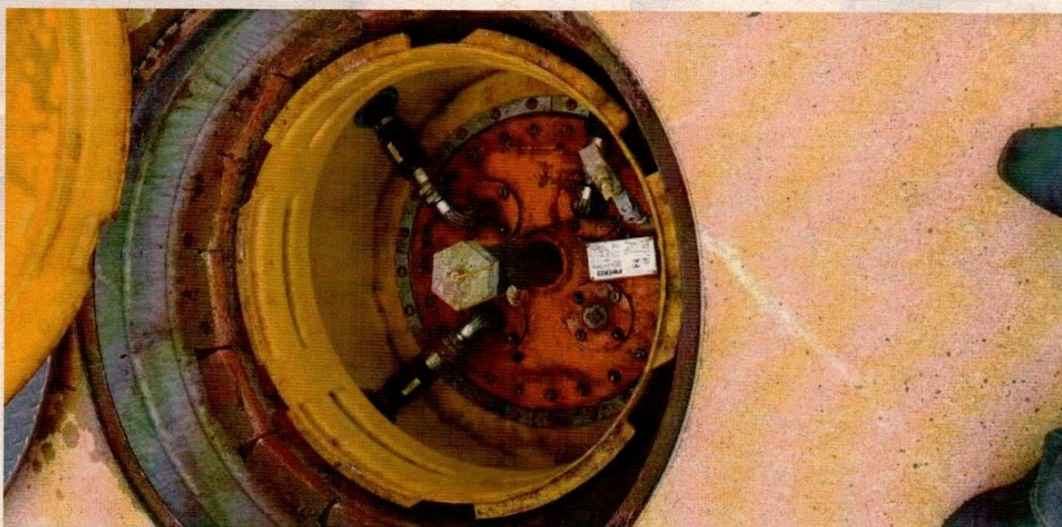
Foto vistoria: Boca de acesso ao tanque com câmara de contenção contra derramamentos (SUMP)
