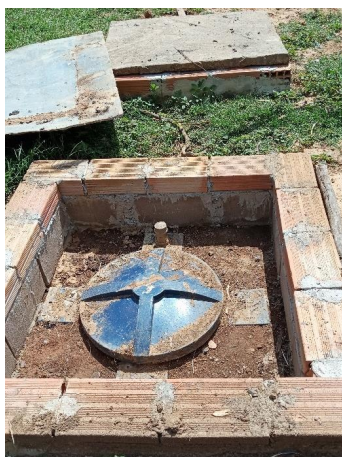
Foto 01. Fossa biodigestora instalada em uma das residências.
