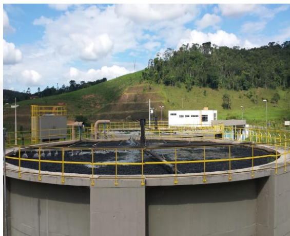
Foto 02. Vista parcial dos filtros biológicos já existentes.
