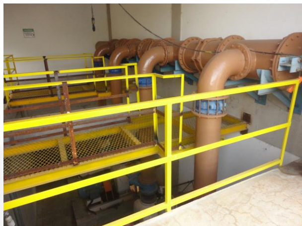
Foto 08. Elevatória de esgoto bruto.
