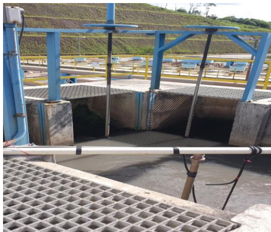
Foto 01. Vista parcial dos reatores UASB já existentes.
