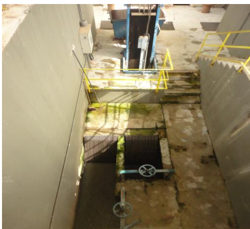
Foto 07. Tratamento Preliminar - Gradeamento
