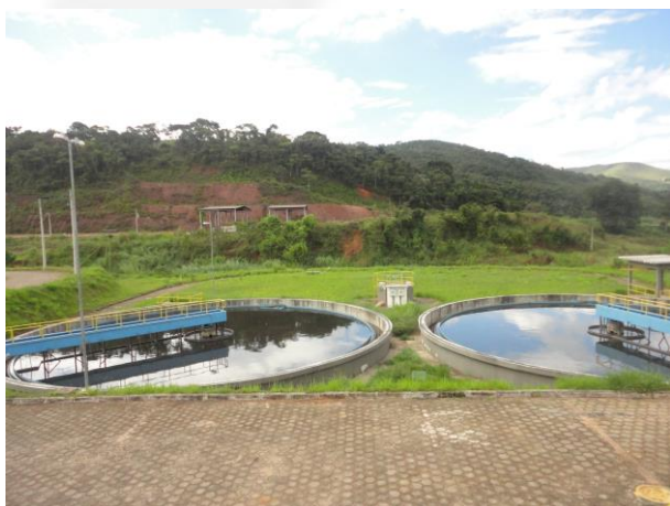
Foto 03. Vista parcial dos decantadores secundários.
