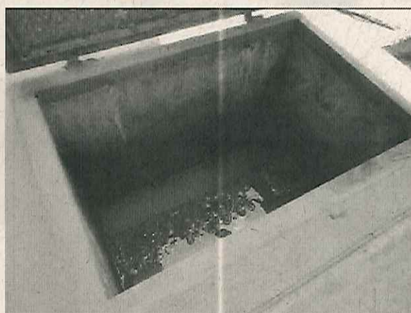
Foto 10. Caixa separadora água/óleo (SAO).
