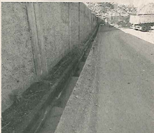
Foto 07. Sistema de drenagem pluvial.
