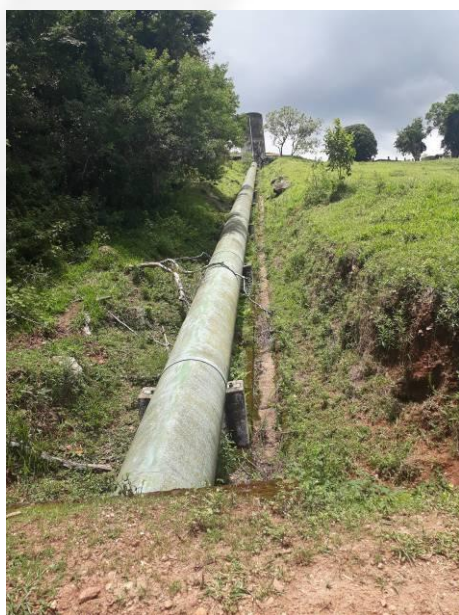
Foto 03. Chaminé de equilíbrio e conduto forçado
