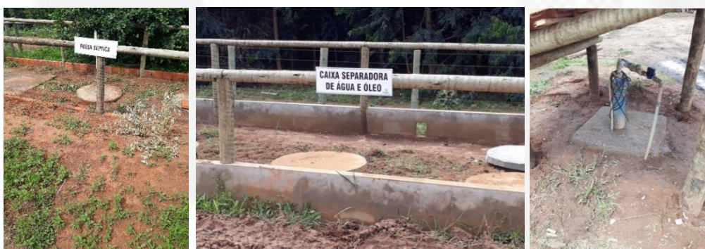
Fotos 8, 9 e 10 – Fossa séptica, Caixa SAO e captação subterrânea em poço tubular profundo.
