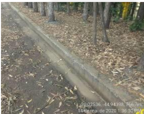
Foto 07. Canaletas para drenagem pluvial.
