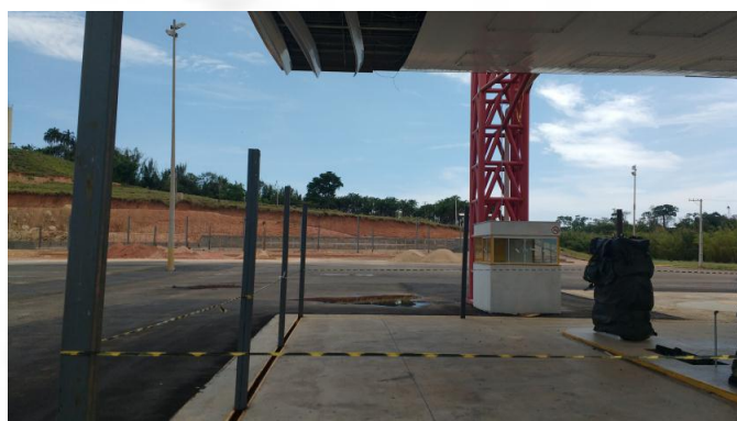
FIGURAS 03 e 04 – Cobertura Metálica com pontos da forração caindo
