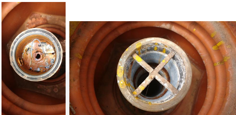
FIGURAS 05 à 12 – Bocas de descarga dos tanques
