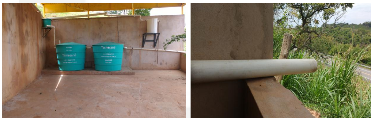
FIGURAS 15 e 16 – Tanque Séptico, Filtro Anaeróbio e tubulação direcionada para o solo
