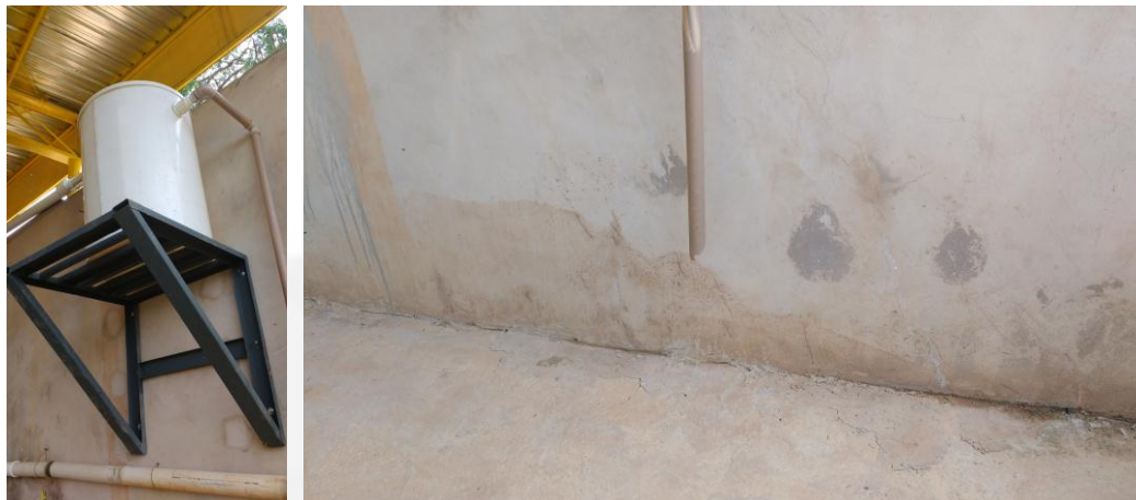
FIGURAS 13 e 14 - Caixa Separadora de Água e Óleo – SAO e tubulação direcionada para o chão
