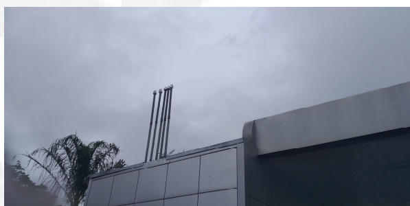
Válvulas de exaustão de vapores
