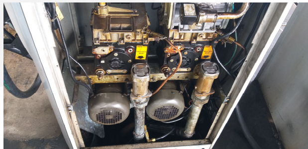
Bombas de Abastecimento com ckeck Valve e Sump
