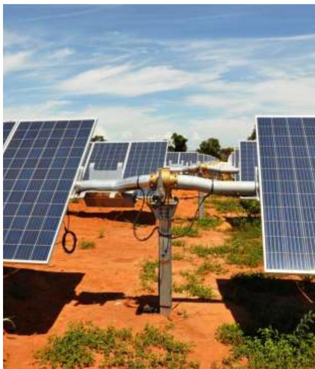
Figura 5 – Painéis fotovoltaicos com seguidores
