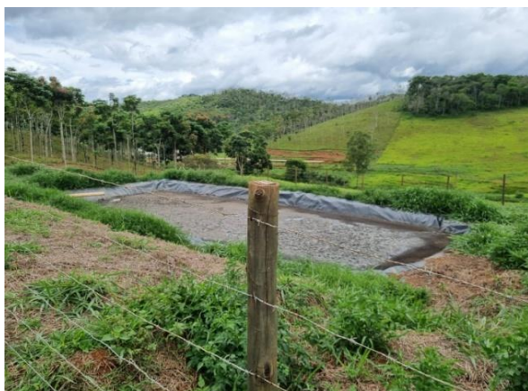
Imagem 05 e 06: caixa de contenção de sólidos e lagoas anaeróbias.
