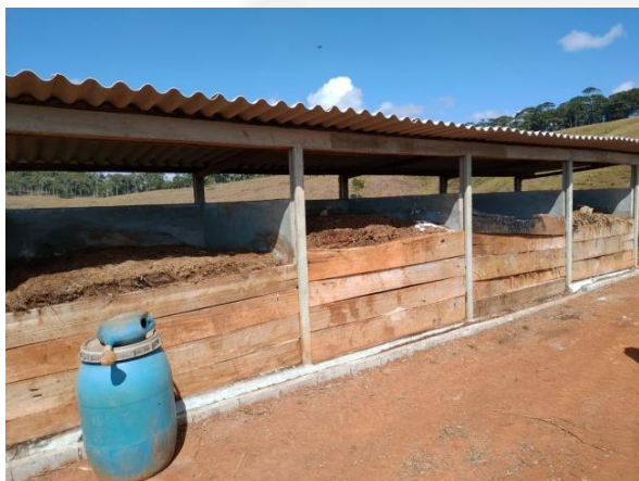
Imagem 07 e 08: composteira com canaleta para contenção de chorume.
