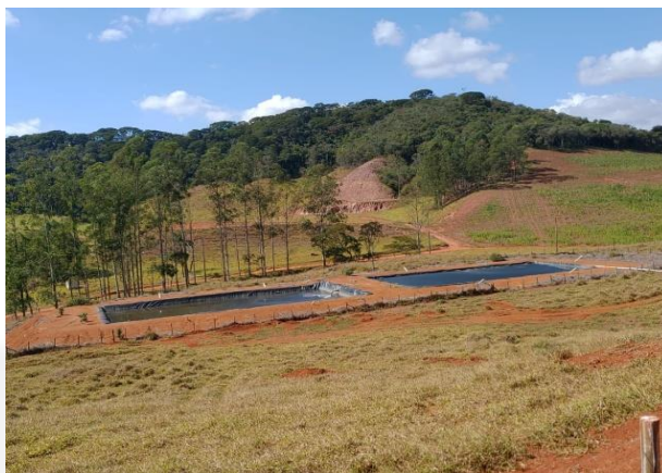
Imagem 05 e 06: caixa de contenção de sólidos e lagoas anaeróbias.
