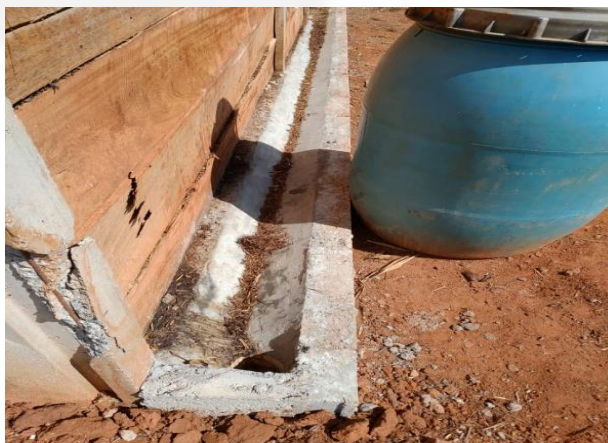
Imagem 07 e 08: composteira com canaleta para contenção de chorume.
