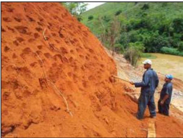
Foto 29: Microcoveamento dos taludes
