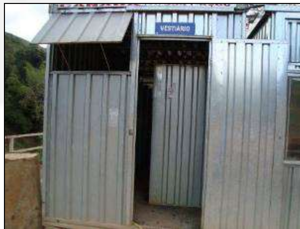
Foto 19: Vestiário/sanitários instalados no canteiro central.
