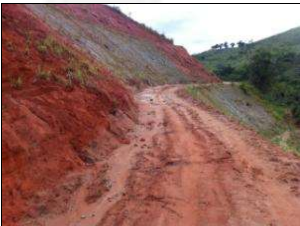
Foto 37: Taludes e sistema de drenagem pluvial antes das adequações.
