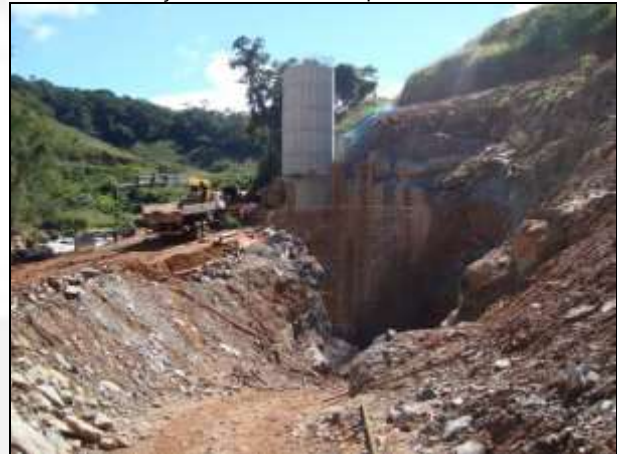
Foto 4: Construção da casa de força
