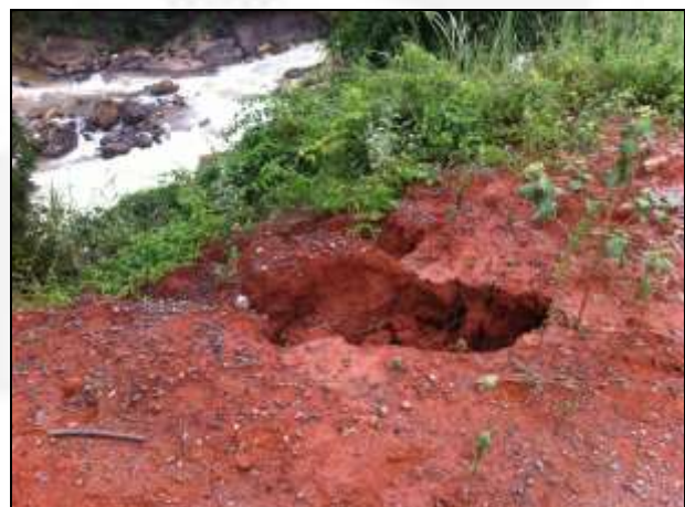
Foto 36: Processo erosivo em estágio inicial se instalando às margens do rio Carangola, em área de solo exposto em virtude da ausência de recomposição vegetal.
