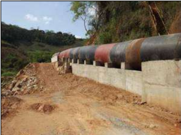
Foto 3: Instalação dos condutos
