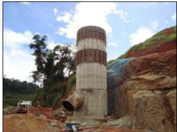
Foto 2: Construção da chaminé de equilíbrio
