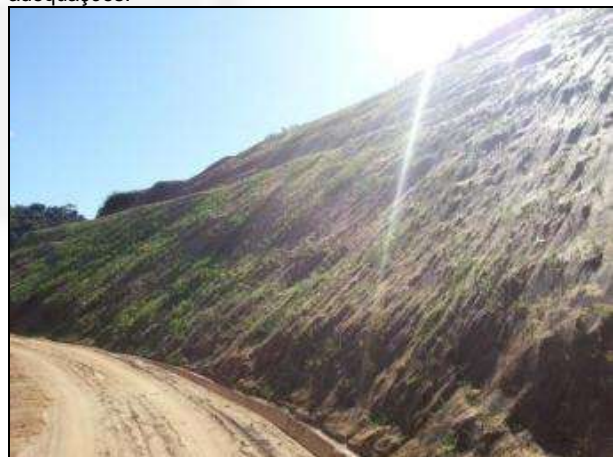
Foto 40: Taludes e sistema de drenagem pluvial após as adequações.
