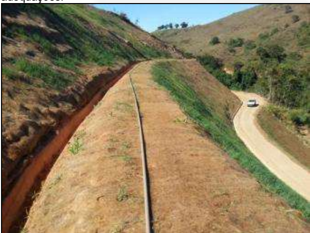
Foto 39: Taludes e sistema de drenagem pluvial após as adequações.
