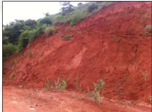
Foto 34: Talude à montante da casa de força onde as atividades de plantio previstas no Plano de Recuperação de Áreas Degradadas – PRAD não foram executadas.
