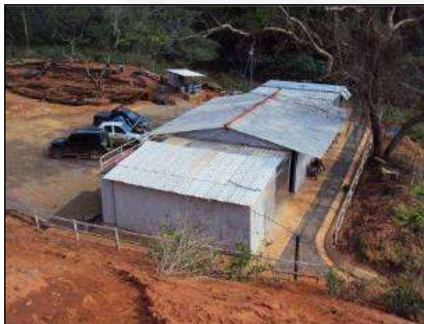
Foto 18: Vista geral do canteiro de obras, instalado sobre base de concreto, dotada de sistema de drenagem de águas pluviais.
