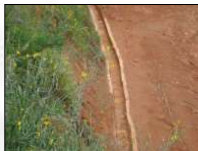
Foto 22: Canaletas de drenagem
