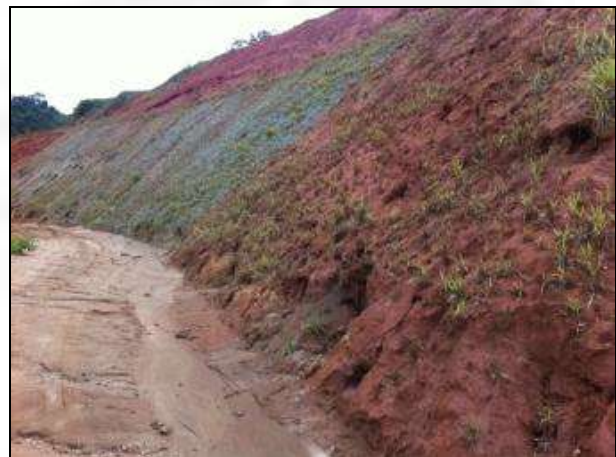
Foto 38: Taludes e sistema de drenagem pluvial antes das adequações.
