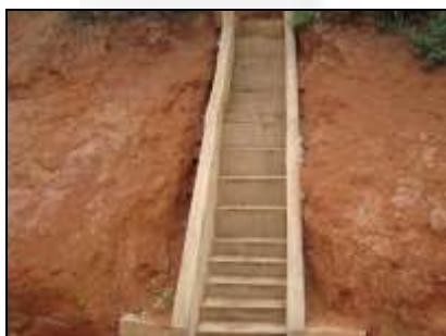
Foto 20: Escadas de dissipação
