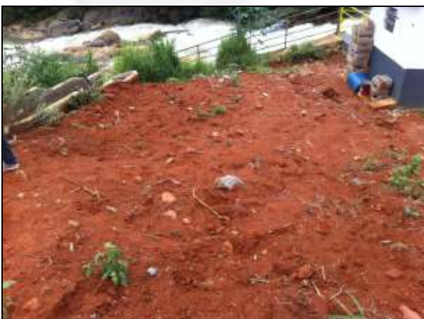
Foto 35: Área de solo exposto, localizada às margens do rio Carangola, devido à ausência de recomposição vegetal.
