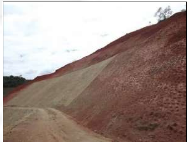
Foto 30: Aplicação de biomanta
