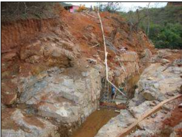
Foto 1: Construção da Tomada d'água
