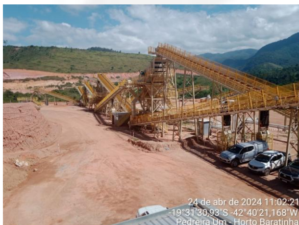
Foto 3: Vista da UTM.
