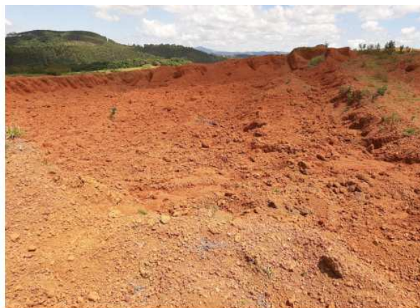
8- Preparação de cava para recebimento de estéril
