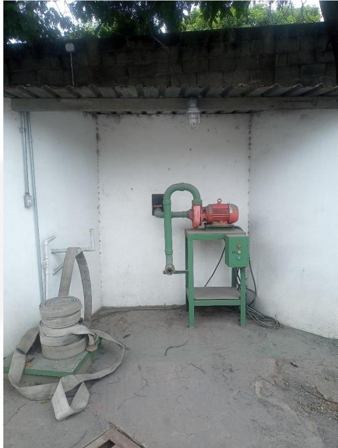
**Figura 5.3.1. Aspersor fixo utilizado para umidificar o pátio de material.**
