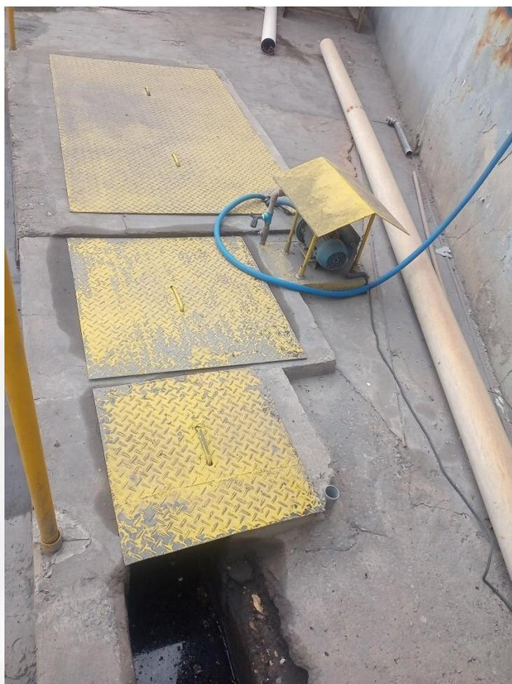
**Figura 5.1.1. Caixa SAO e bomba de recirculação de água.**
