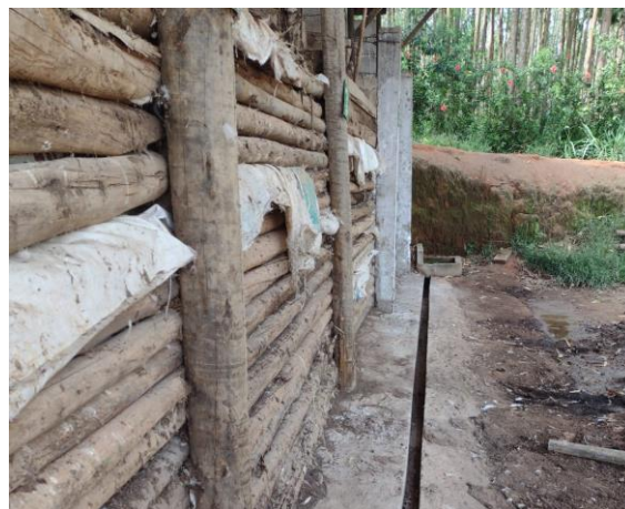
Foto 06. Composteira, canaleta de drenagem de chorume e caixa estanque para armazenamento do material.
