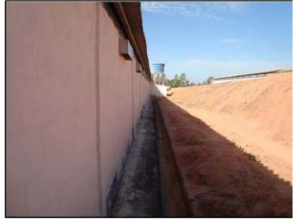
Foto 02. Canaletas de drenagem pluvial
