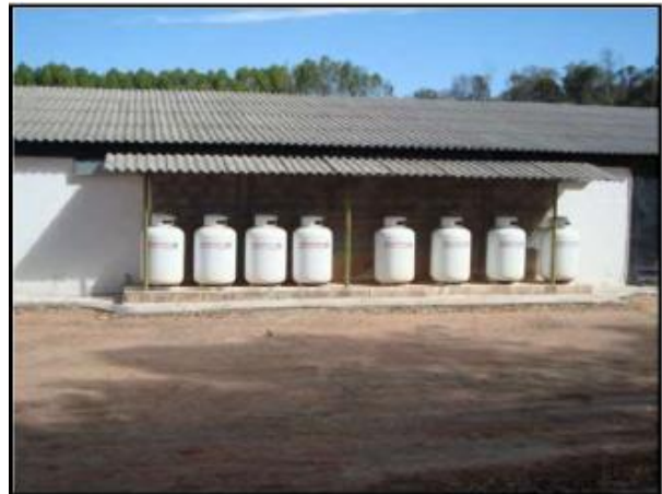
Foto 04. Armazenamento do gás GLP (aquecimento dos pintainhos).
