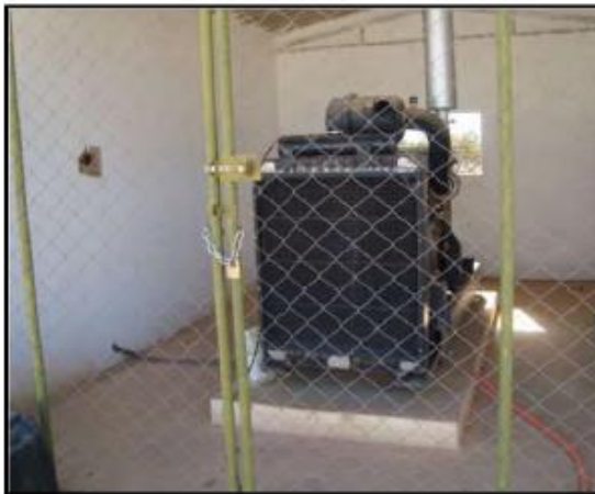
Foto 03. Gerador a diesel (utilizado em caso de falta de energia).
