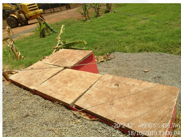
Figura 9. Caixa separadora de água e óleo
