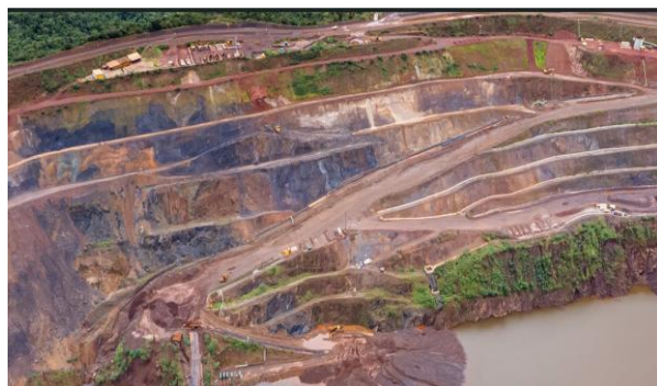
Foto 1 - Obras de retaludamento das paredes Sul e Leste da Cava, em andamento.
