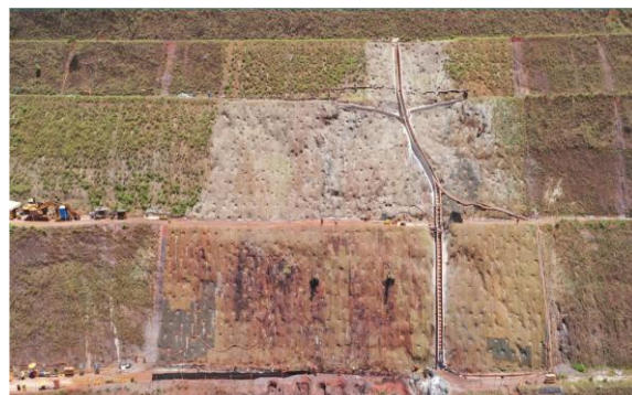
Foto 2 - Obra de estabilização das erosões da parede Norte da Cava.
