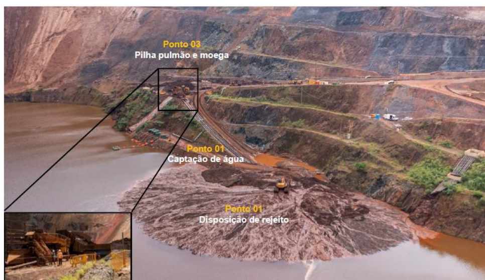
Figura 6 - Moega no Ponto P03 com desvio hidráulico para o Ponto P01. Fonte: Relatório Anual de Disposição de Rejeito na Cava da Mina Córrego do Feijão, 2025.
