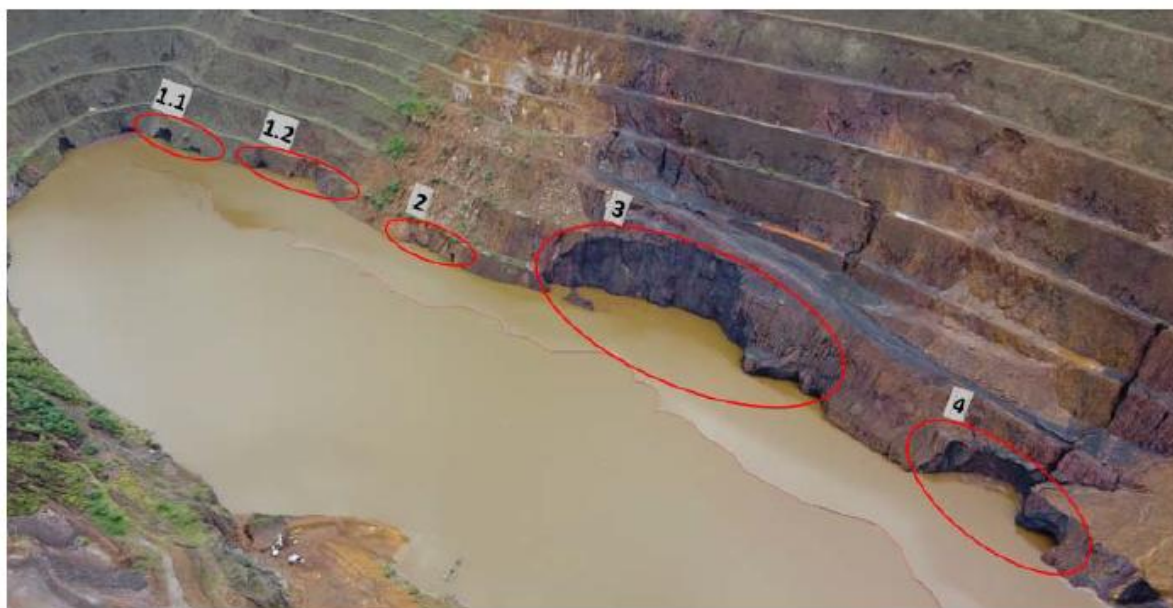
Figura 9 - Localização das erosões na parede norte da cava Córrego do Feijão (dezembro/21): Fonte – Vale S.A., RAS 2024.
