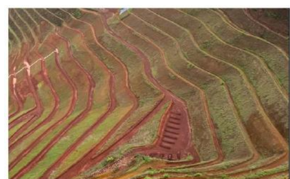
Foto 4 - Vista geral do Aterro Norte (antiga PDE Norte) e canaletas de drenagens implantadas.
