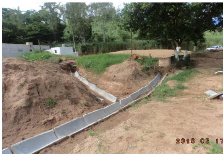
FOTO N° 777 CANALETAS E MURO
