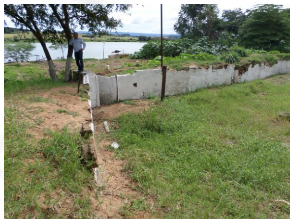
FOTO 2 – Paliçada de contenção com Rio Grande ao fundo.
