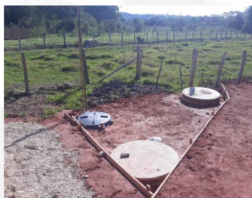
Foto 6: Estação de tratamento de efluentes sanitários
