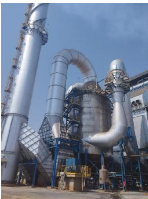
Foto 03. Lavador de gases da caldeira.
