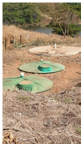
Foto 02. Sistema de Tratamento de Efluente Sanitário
