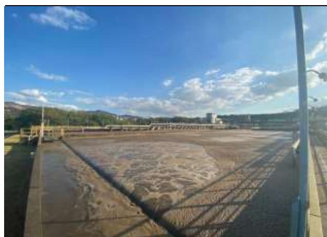
FOTO 3 – Tanque de aeração (reator).
