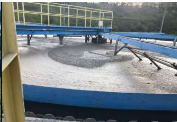
FOTO 8 – Adensadores por flotação.
