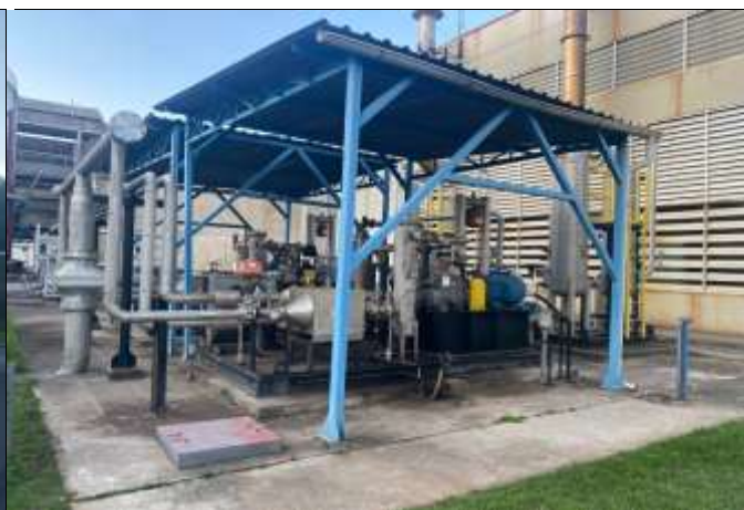
FOTO 12 – Tratamento do biogás na PCT.
