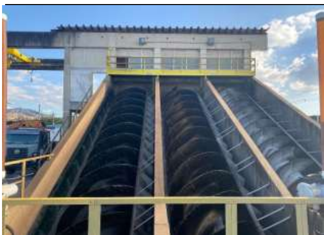
FOTO 5 – Elevatória de lodo.
